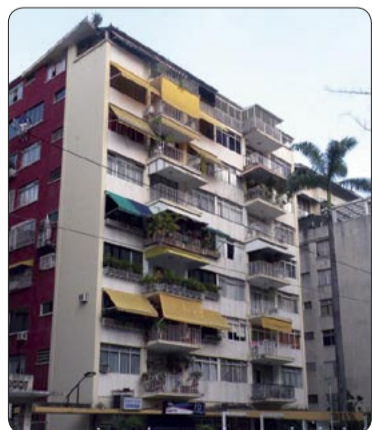
La Ordenanza de Inmuebles Urbanos establece cambios en la tabla de valores
